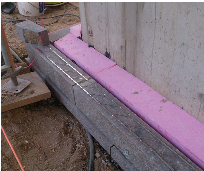
mit MURINOX®-Lagerfugenbewehrung verstärktes Mauerwerk
