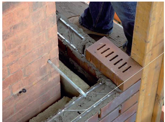
mit MURINOX®-Lagerfugenbewehrung verstärktes Mauerwerk
