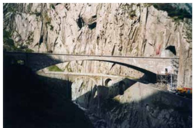
Sanierung Teufelsbrücke im Kanton Uri Renovation of the «Teufelsbrücke» in the Canton Uri
